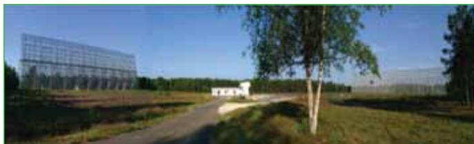
*Figure 8. Le grand radiotélescope de Nançay, état vers 1995. On voit à gauche le miroir plan de 200x40 m, orientable autour d'un axe est-ouest, qui renvoie le rayonnement radio du ciel sur le miroir concave fixe de 300x35 m, à droite. Celui-ci concentre le rayonnement sur une antenne focale placée sur le chariot mobile visible au centre. Le bâtiment de réception visible derrière le chariot est actuellement déplacé en dehors du trajet des ondes radio.*
